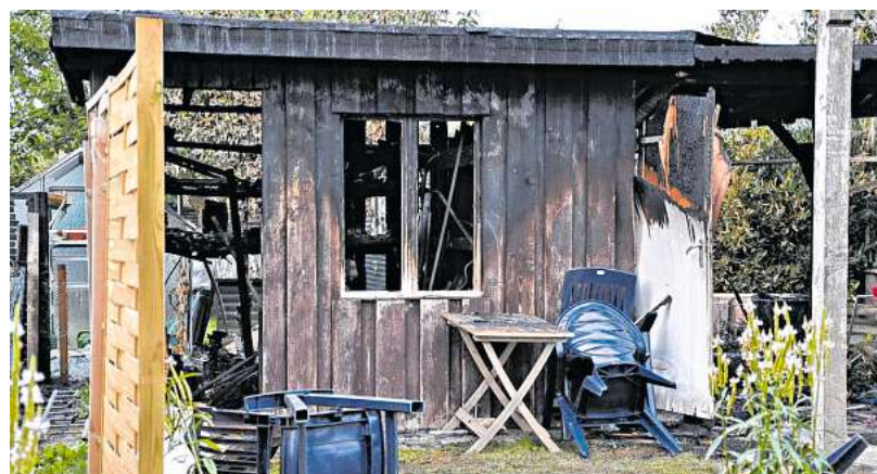
Das Gerätehaus auf dem Gelände brannte komplett aus. FOTO: HOLGER KRÖGER
