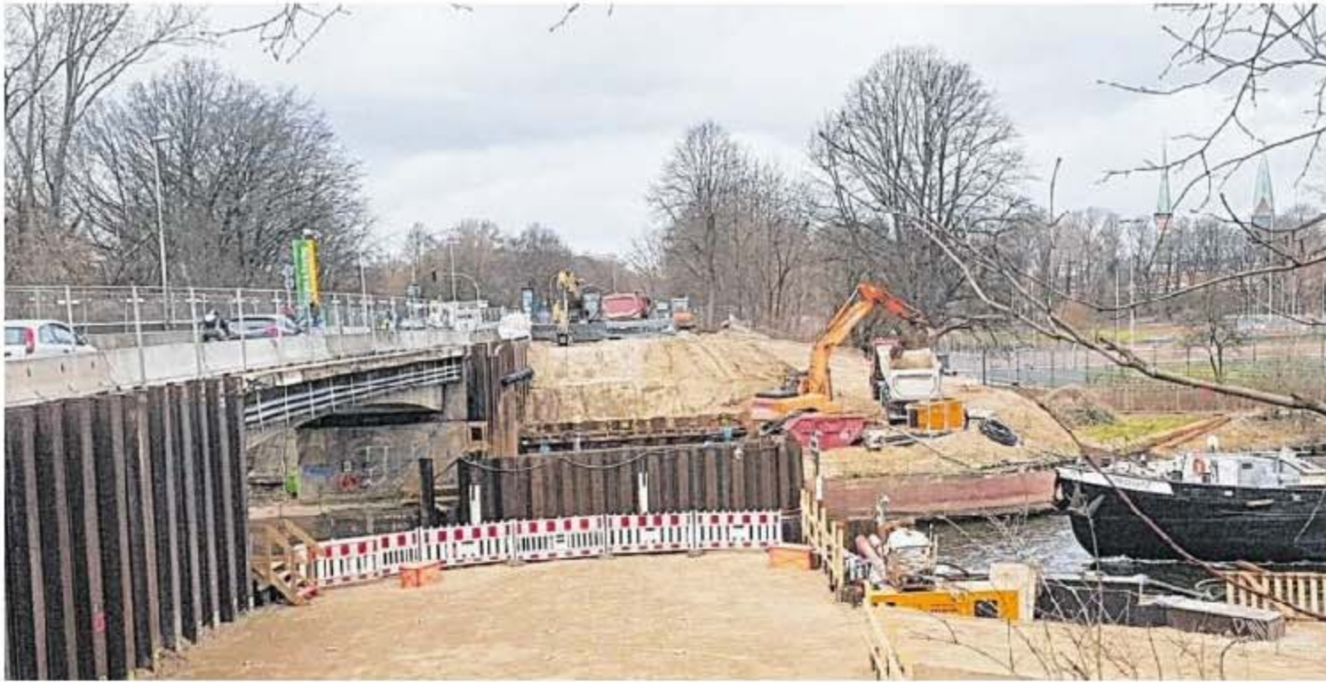
Baustelle Possehlbrücke: Seit März 2015 ist ein Teil der alten Brücke abgerissen. Noch ist nichts von der neuen Querung zu sehen. FOTO: KRÖGER
